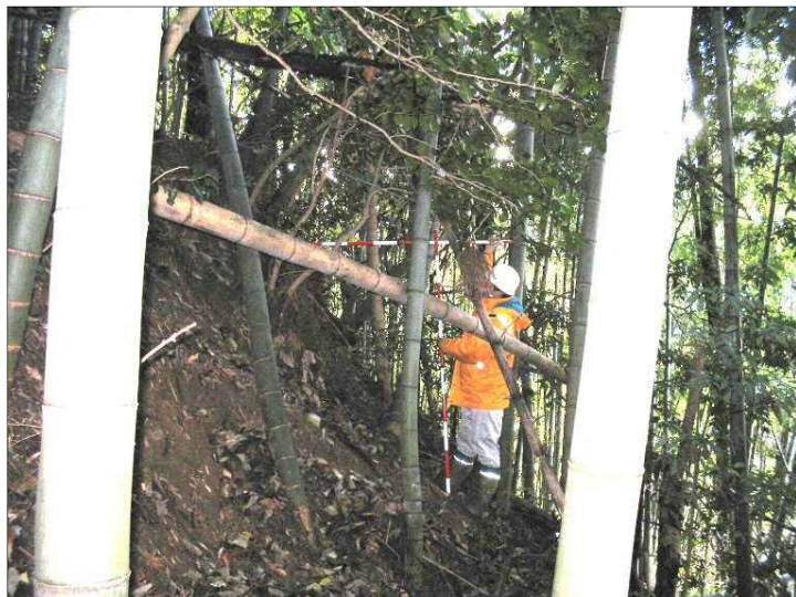
林内クラック発生状況
