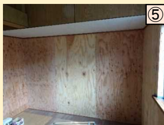
床や天井を解体せずに設置した2階補強壁 (上下空き)
