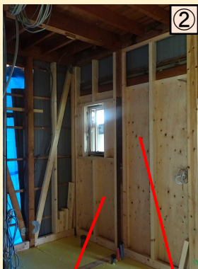
採光等を確保しつつ地震に耐える壁設置 (窓空き)
