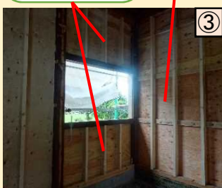
採光等を確保しつつ地震に耐える壁設置 (窓空き)
