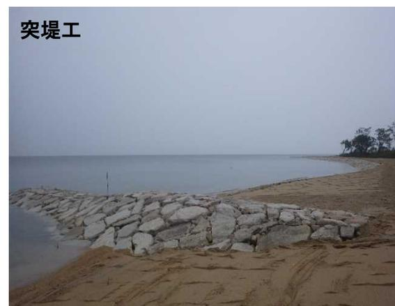
● 突堤工と養浜工の施工により、砂浜が確実に復元されていることが確認できる。
