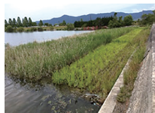
底質改善対策 (覆土工・植生工)
