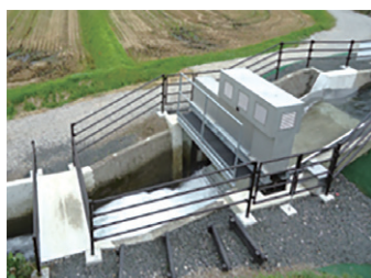
農業用水路の落差を利用した小水力発電 （米原市姉川沿岸土地改良区）
