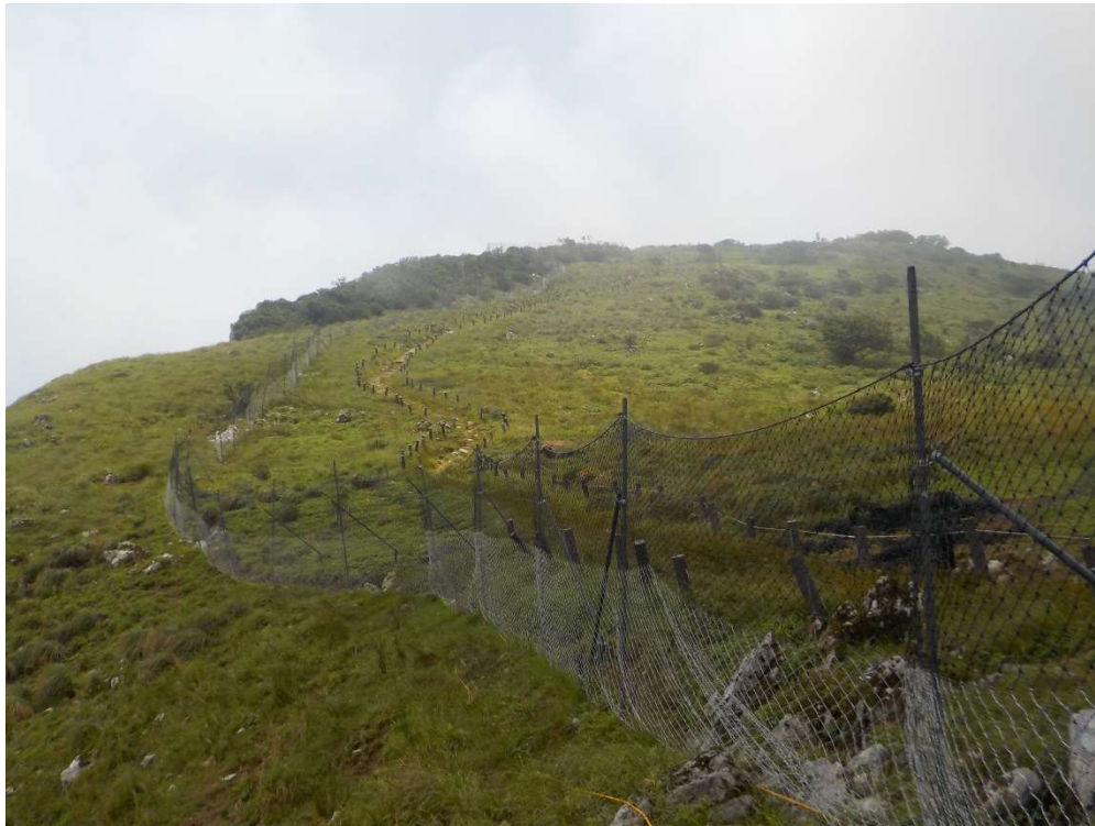
東登山道エリア植生防護柵の修復 （下部に強化繊維が入ったネットに交換）
