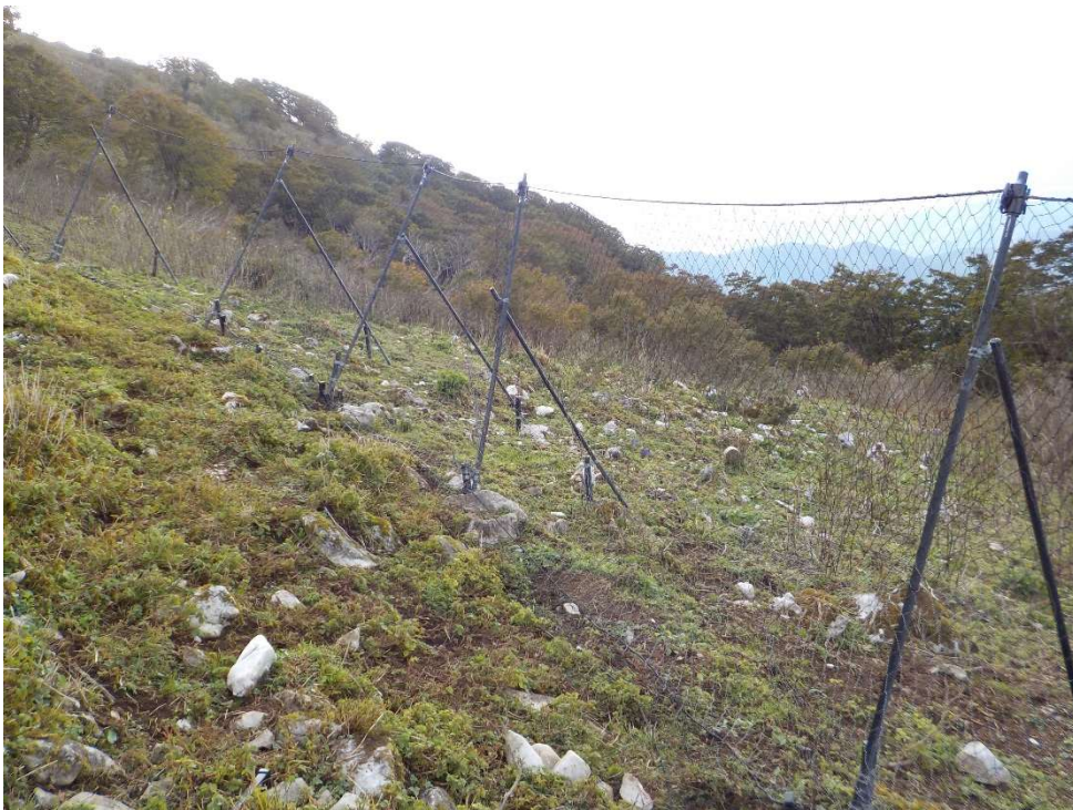
西登山道エリア植生防護柵の修復（張り替えを実施）
