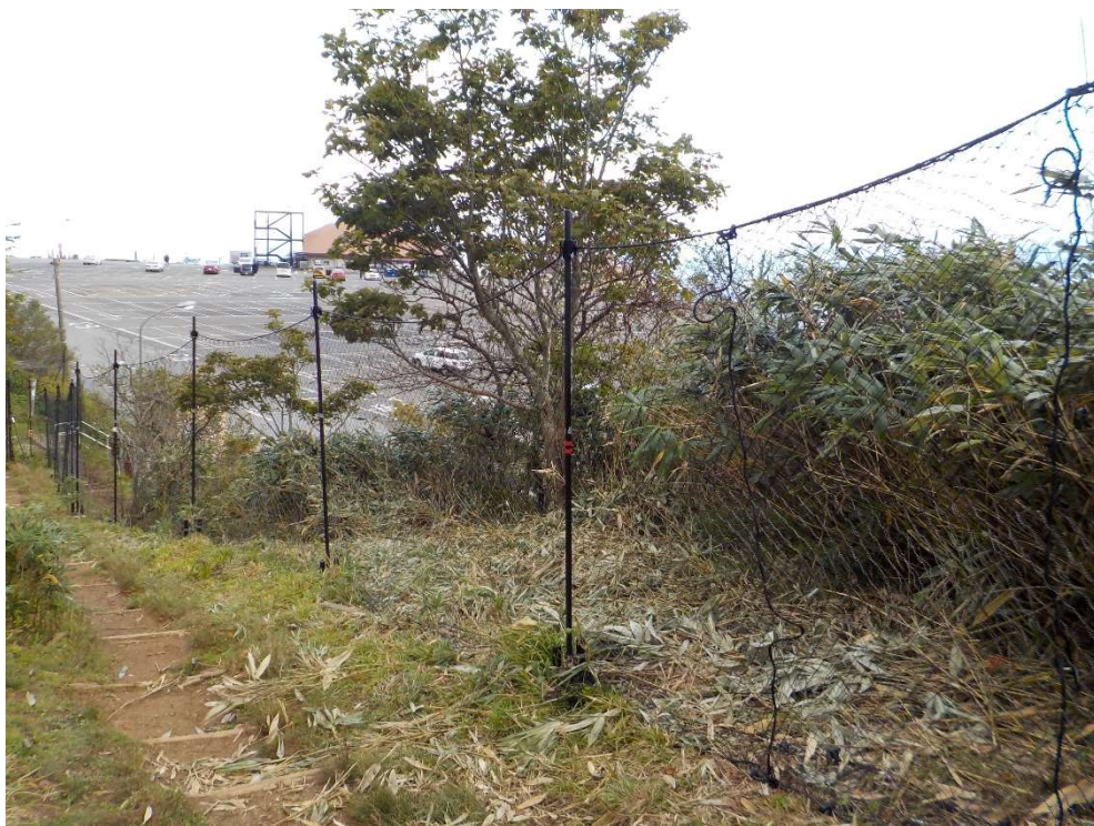
東登山道エリア植生防護柵の修復 （下部にステンレスが入ったネットに交換）
