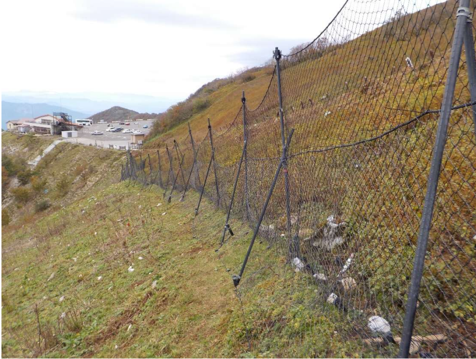
西登山道エリア植生防護柵の修復 （外側から新補強ネットを付け足す）
