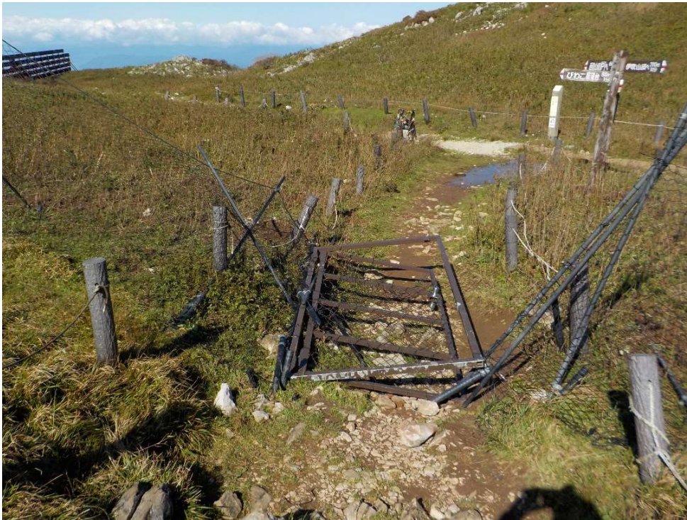
台風１９号によって倒壊したゲート
