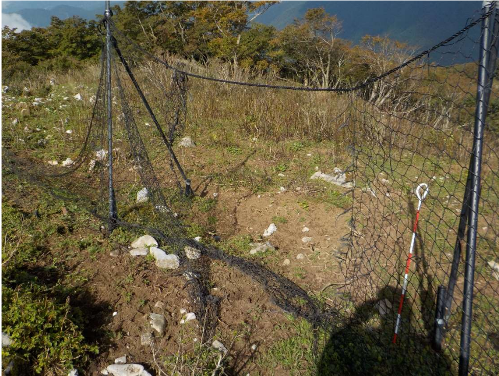
西登山道エリア植生防護柵のダメージ（ネットが大きく開いている）
