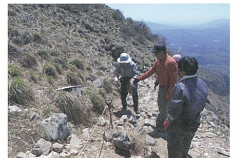
保全のため登山道に鉄杭を設置
