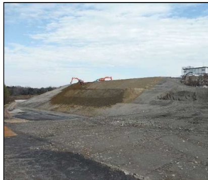
④ キャッピング工 DE工区の覆土法面整形を行っています。
