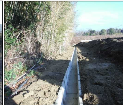
⑤ 雨水排水工 西市道側U字型側溝据付状況です。
