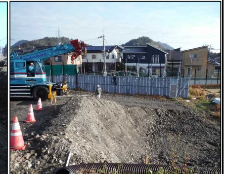
⑤ 雨水排水工 北尾団地側工事準備として万能板の撤去を行っています。
