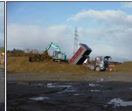
④ キャッピング工 覆土の受け入れを行っています。
