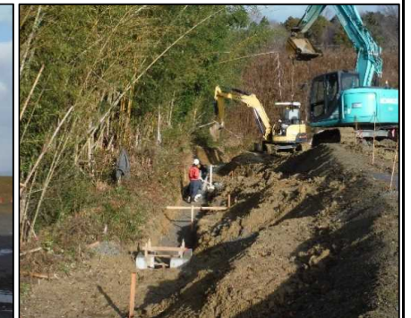
⑤ 雨水排水工 側溝の掘付を行っています。
