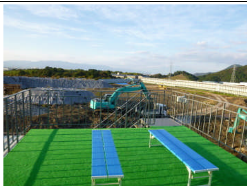
見学ステージより現場全景
