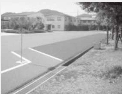
衛生陶器屑を使用した舗装用資材
