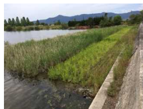
底質改善対策 （覆土工・植生工）
