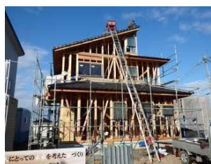
びわ湖材を使用した住宅
