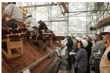
県指定有形文化財 阿自岐神社本殿 保存修理工事現場公開
