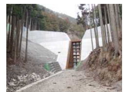
日野谷川堰堤(甲賀市)
