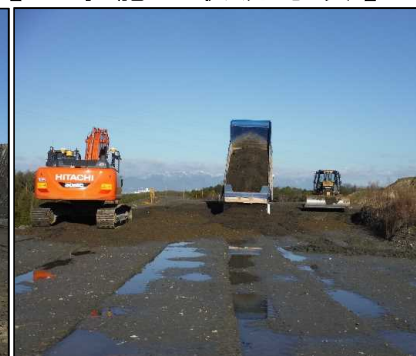
② 選別土仮置・盛土工 DE工区の盛土を行っています。
