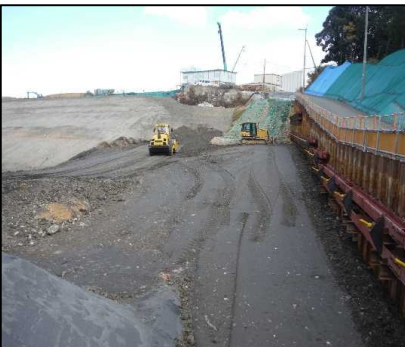
② 選別土仮置・盛土工 E工区の盛土を行っています。
