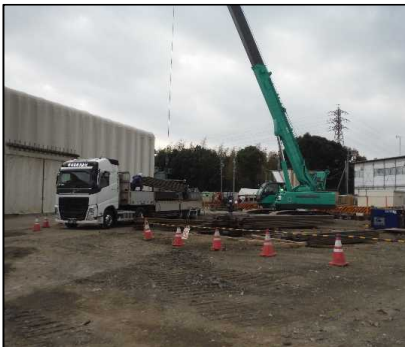
① 有害物掘削工 E区画の鋼矢板を搬出しています。
