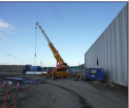
③ 選別処理工 集塵機の撤去を行っています。
