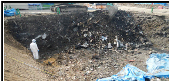
D追加区画掘削状況
