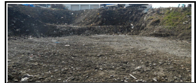
旧焼却炉跡基礎撤去
