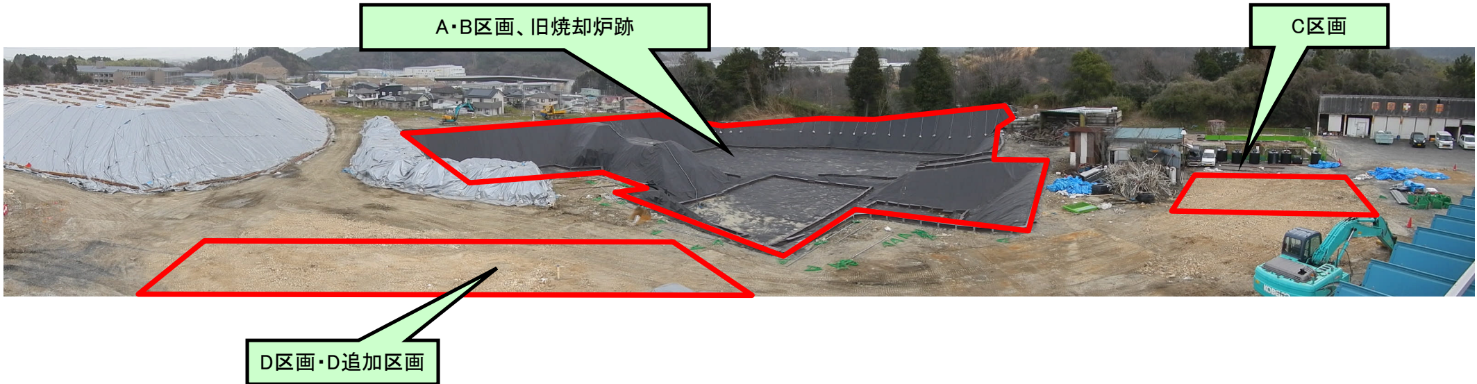
【工事完了写真】 [平成25年3月18日撮影]
