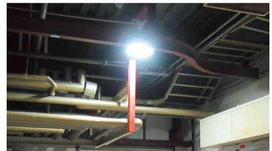
インダクションライト（無電極照明）は、発光管内に消耗品のフィラメントや電極がなく、インバーターにより高周波電流を供給し、電磁誘導と放電により発光する照明技術。
