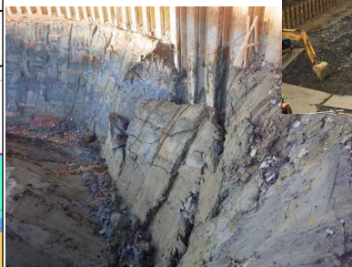
写真-1 C工区状況写真
