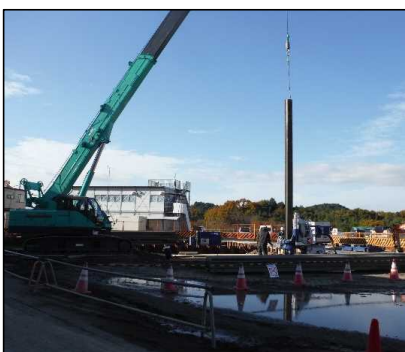
① 有害物掘削工 E区画の鋼矢板を引き抜いています。
