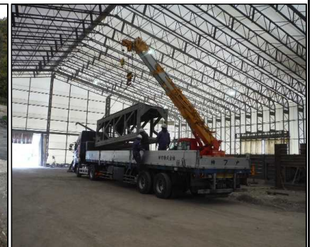
③ 選別処理工 選別プラントの解体搬出を行っています。
