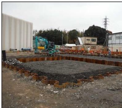
① 有害物掘削工 E区画埋戻しが完了しました。
