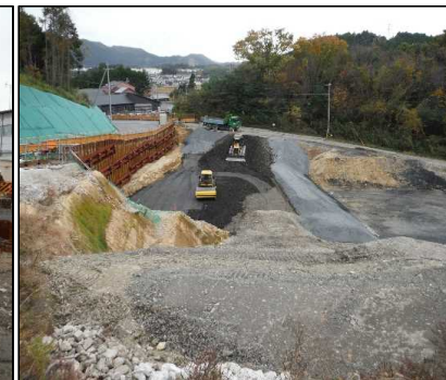
② 選別土仮置・盛土工 E工区の埋戻しを行っています。
