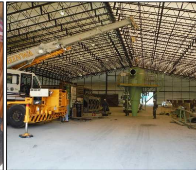
③ 選別処理工 選別プラントを解体しています。
