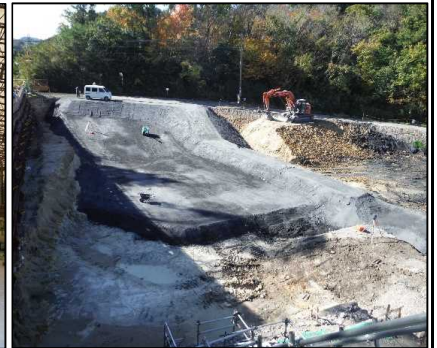
④ 底面・側面遮水工 E工区底面・側面遮水工が完了しました。
