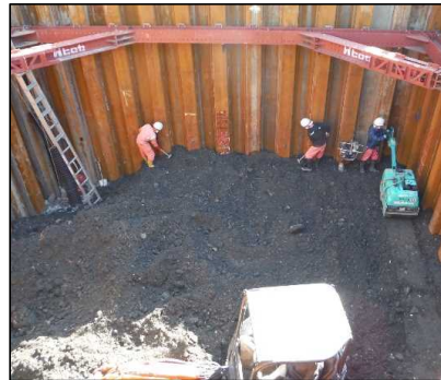
① 有害物掘削工 E-1区画を埋め戻しています。
