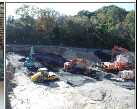
④ 底面・側面遮水工 底面遮水を施工しています。
