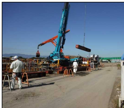
① 有害物掘削工 E-2、3区画の支保工を解体しています。
