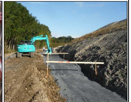
④ 底面・側面遮水工 側面遮水を施工しています。
