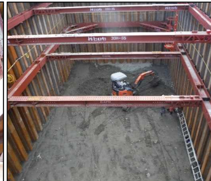
① 有害物掘削工 E-2、3区画を埋戻しています。
