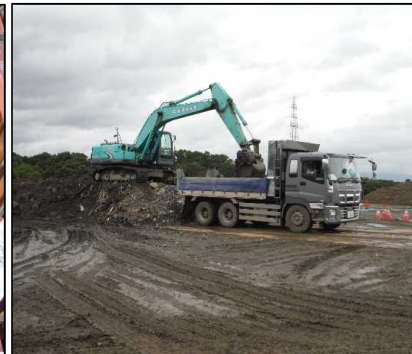
① 有害物掘削工 仮置き有害物土を外部搬出しています。
