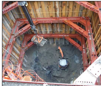
① 有害物掘削工 E-1区画の有害物土を掘削しています。
