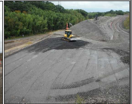
② 選別土仮置・盛土工 DE工区の盛土を行っています。
