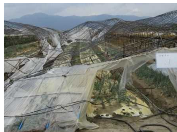
台風21号による農業用ビニルハウスの倒壊（2018年9月）
