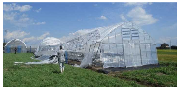
写真 2 台風により新設ハウスの 1/3 が倒壊
