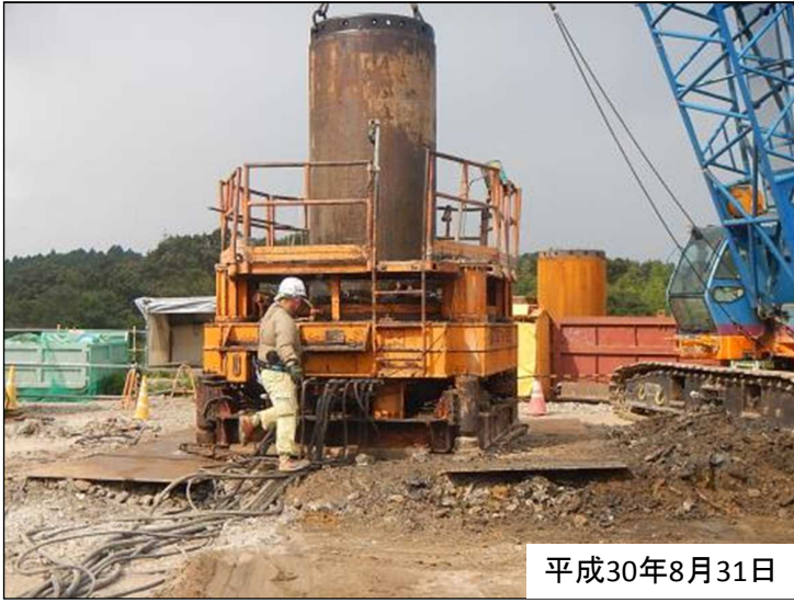
ケーシング設置状況
