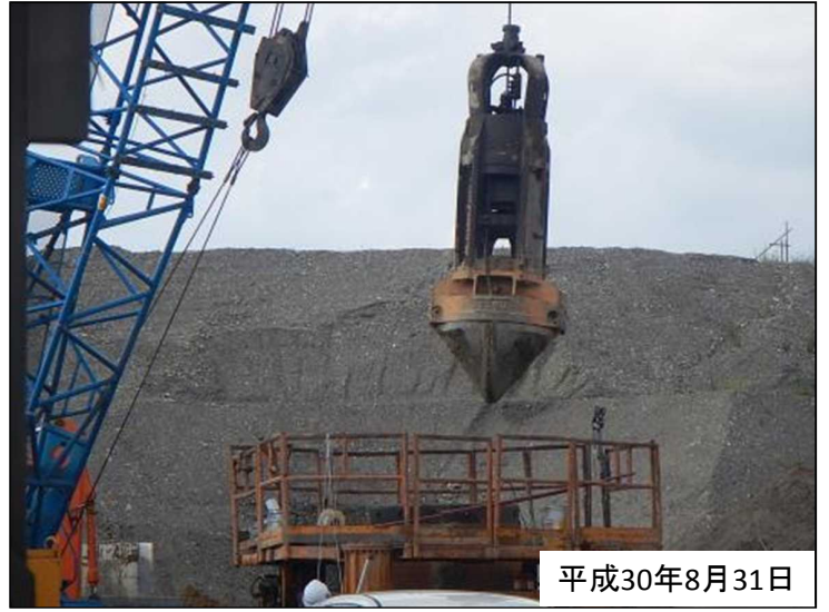
ハンマーグラブ廃棄物土掘削
