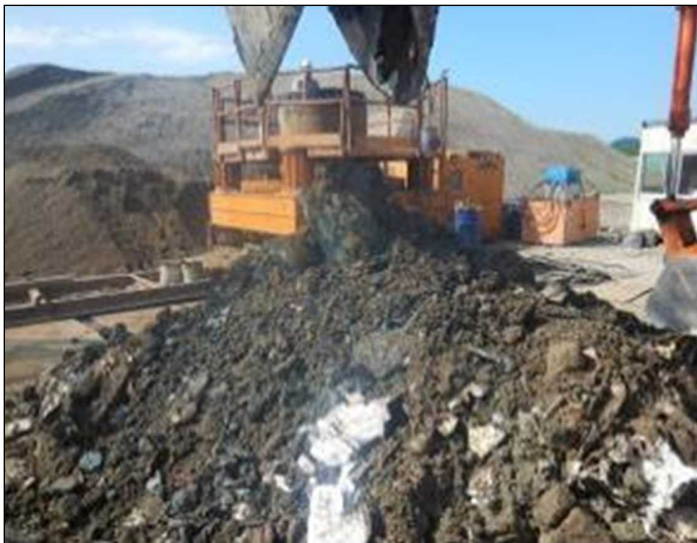
ハンマーグラブ掘削(廃棄物土掘削状況)
