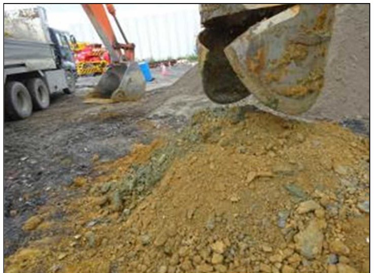
ハンマーグラブ掘削(地山掘削状況)
