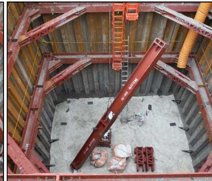
① 有害物掘削工 E-1区画の支保工を設置しています。
