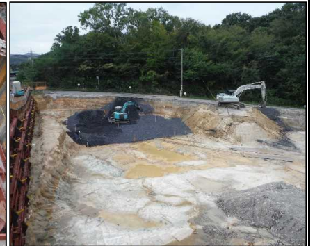
④ 底面・側面遮水工 底面遮水工の基盤整備を行っています。
