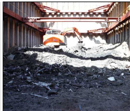
① 有害物掘削工 E区画の廃棄物土を掘削しています。
