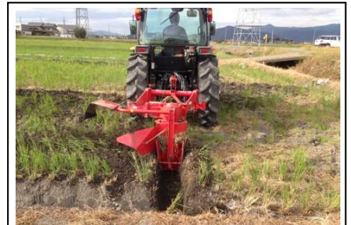
オーガ式溝堀機等で しっかりした排水溝を作る
