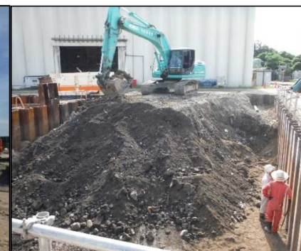
① 有害物掘削工 E区画の掘削を行っています。
