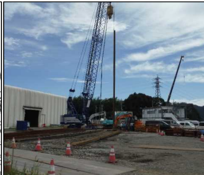
① 有害物掘削工 E区画の鋼矢板を打設しています。
