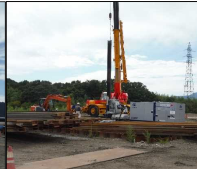
① 有害物掘削工 FG区画の鋼矢板を引き抜いています。
