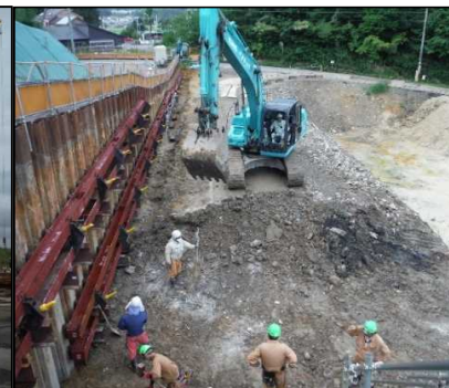
① 有害物掘削工 I区画の掘削を行っています。
