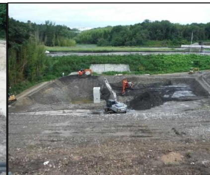
⑤ 洪水調整設備工 調整池堤体の盛土を行っています。
