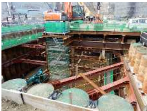
防潮堤を岩盤に設置することから、岩盤まで地盤掘削中
