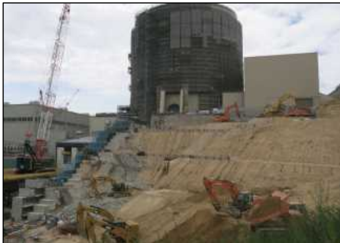
既存高台の掘削
