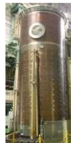
下部炉心構造物
