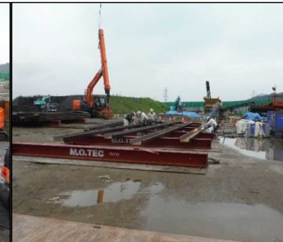
① 有害物掘削工 E区画の鋼矢板を溶接で接続しています。
