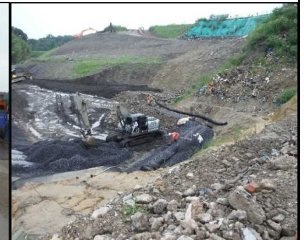
④ 底面排水工 排水管を単粒砕石にて巻き立てています。
