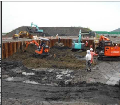
① 有害物掘削工 FG区画の埋戻しをしています。
