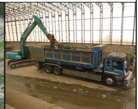
③ 選別処理工 可燃物を外部へ搬出しています。
