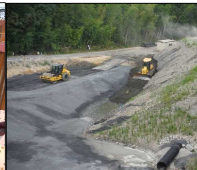
② 選別土仮置・盛土工 DE工区の埋戻しを行っています。
