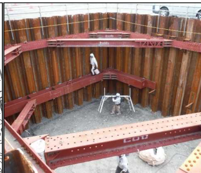
① 有害物掘削工 FG区画の2段目支保工を解体しています。
