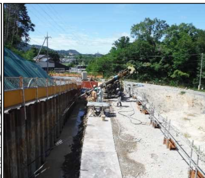
① 有害物掘削工 I区画のアンカー打設を行っています。
