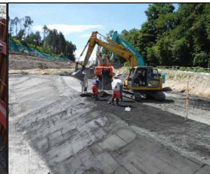
④ 底面・側面遮水工 D・E工区側面遮水工を行っています。
