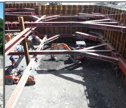
① 有害物掘削工 FG区画の埋戻しを行っています。
