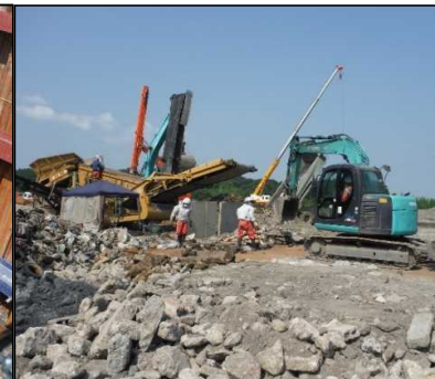
③ 選別処理工 重機と人力で粗選別を行っています。
