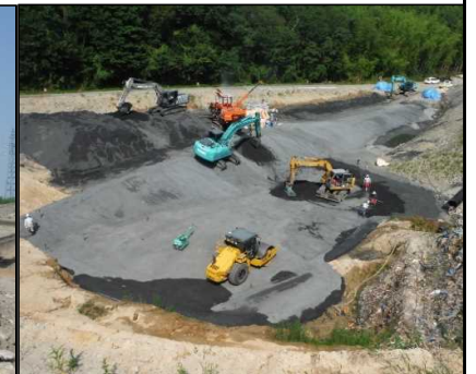
④ 底面・側面遮水工 D・E工区底面遮水工を行っています。
