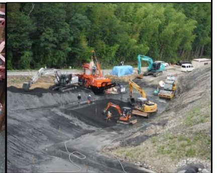
④ 底面・側面遮水工 D・E工区底面遮水工を行っています。
