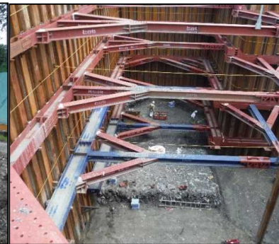
① 有害物掘削工 FG区画の四段目支保工撤去を行っています。
