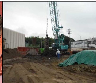
① 有害物掘削工 E区画杭打設部全旋回で掘削していま す。
