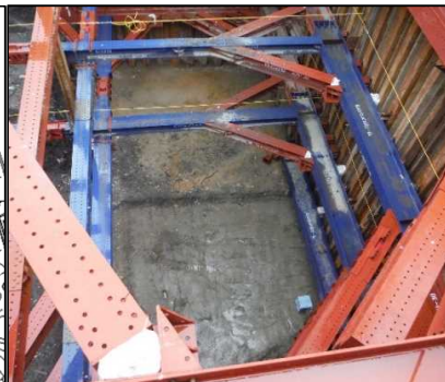
① 有害物掘削工 FG区画の五段目支保工撤去を行って います。
