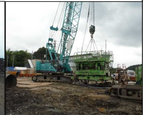
② 有害物掘削工 全旋回掘削機を移動しています。
