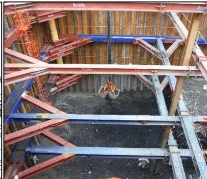
② 有害物掘削工 FG区画の五次掘削を行っています。
