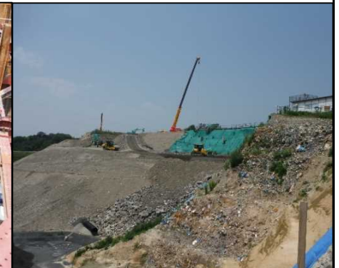
③ 選別土仮置・盛土工
