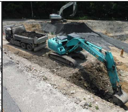
② 有害物掘削工
