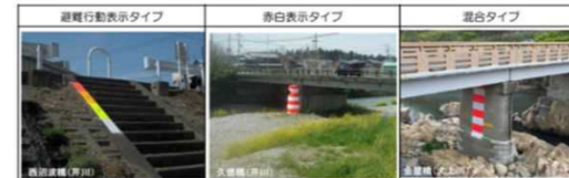
簡易量水標の設置例
