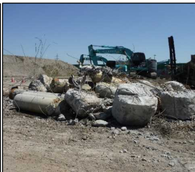
② 有害物掘削工 E区画の全旋回掘削で撤去した基礎コンクリートとPC杭です。
