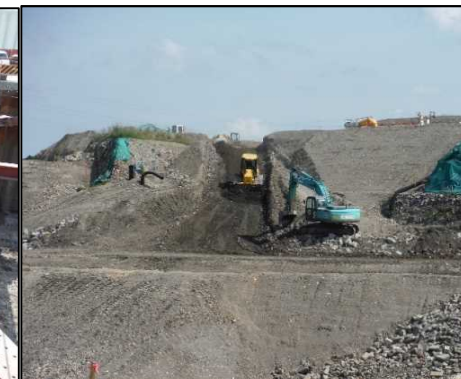
③ 選別土仮置・盛土工 D・E工区盛土を行っています。
