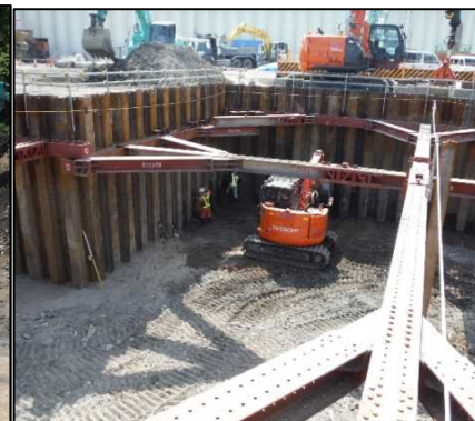
② 有害物掘削工 FG区画の廃棄物土掘削を行っています。
