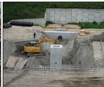
⑥ 洪水調整設備工 接続管部の掘削を行っています。
