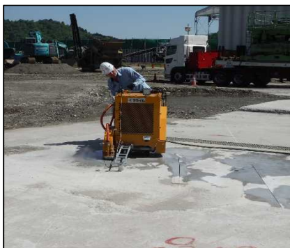
② 有害物掘削工 E区画のカッター切断を行っています。
