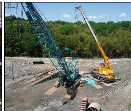
⑤ 底面・側面遮水工 E区画へ移動するためクローラークレーンの解体を行っています。
