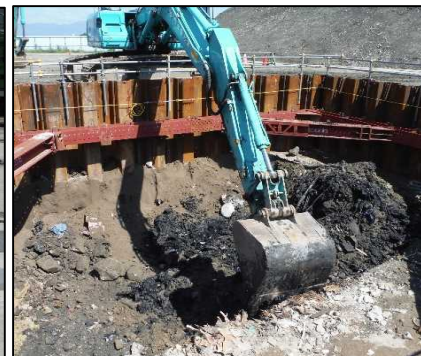
② 有害物掘削工 FG区画の廃棄物土掘削を行っています。
